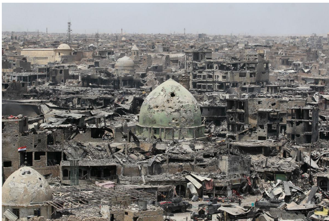
Figura 11 Escombros da cidade de Mosul, Iraque.
