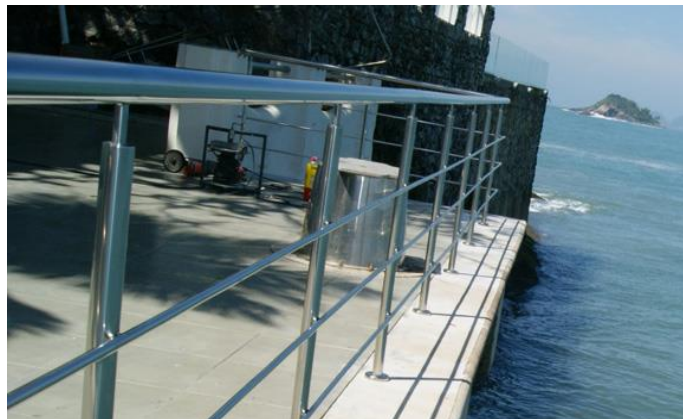
Figura 15 - Guarda-corpo soldado por processo MIG
